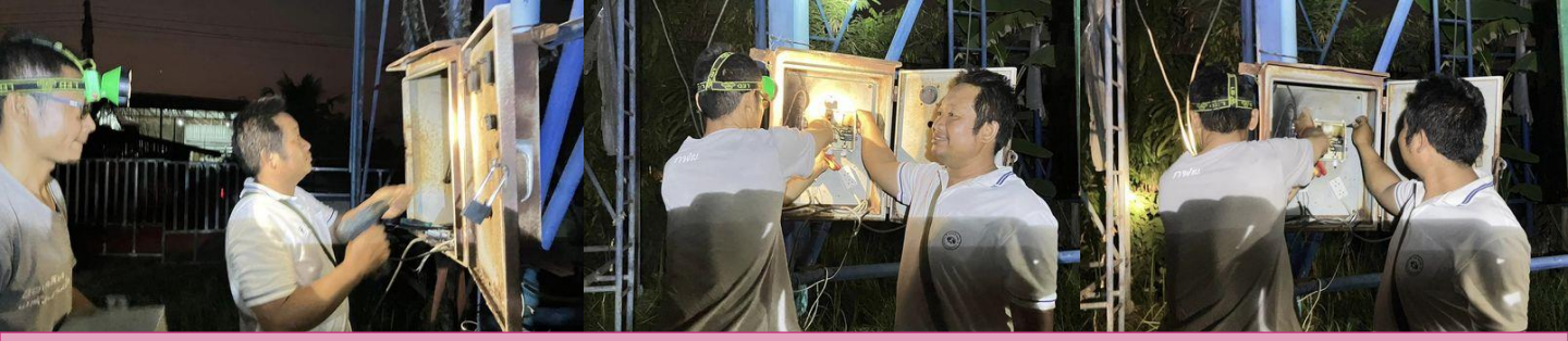
๒๒ กุมภาพันธ์ ๒๕๖๗ เวลา ๑๙.๐๐ น. นายคำพูล พันพุดม นายกองค์การบริหารส่วนตำบลโนนค้อ มอบหมายให้ กองช่างองค์การบริหารส่วนตำบลโนนค้อ ออกซ่อมแซมปั้มซัมเมอร์ส ณ บ้านโนนสว่าง หมู่ที่ ๙
